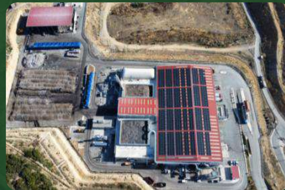
Μονάδα Επεξεργασίας Απορριμάτων Αλεξανδρούπολης 700KWp + 200KWh αποθήκευση (BESS)
